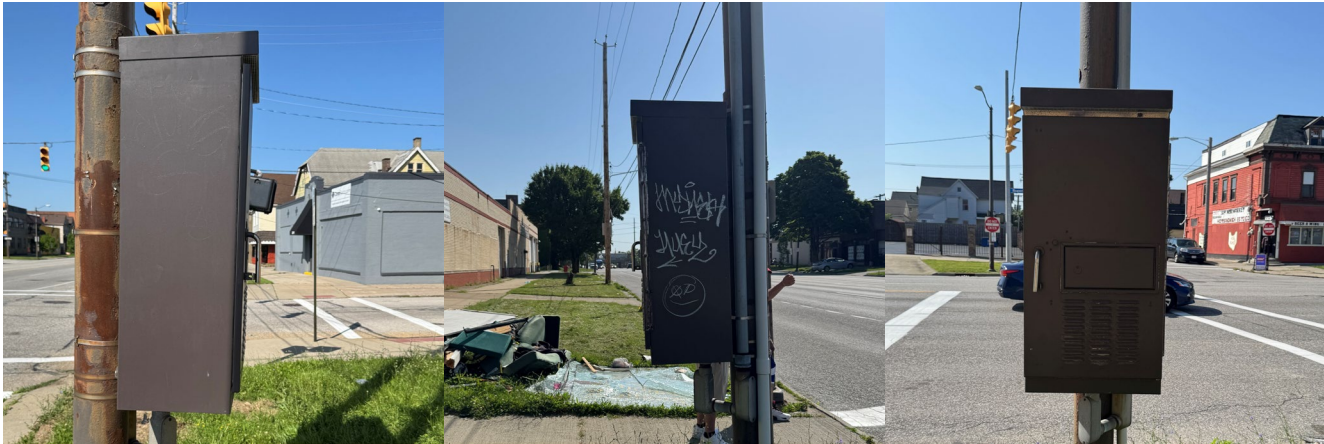
Utility Box Condition (L: 17.5” W: 24” H: 51”)
